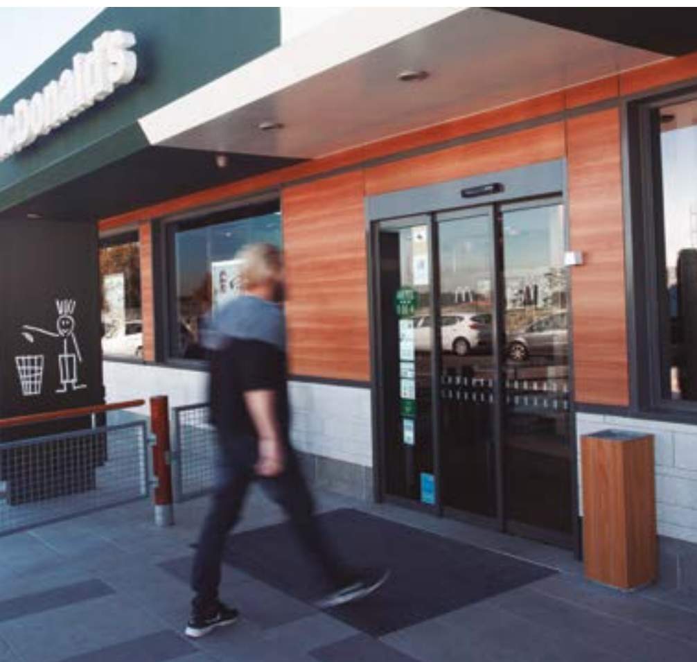
Porta automatica ad apertura telescopica. Settore ristorazione.
